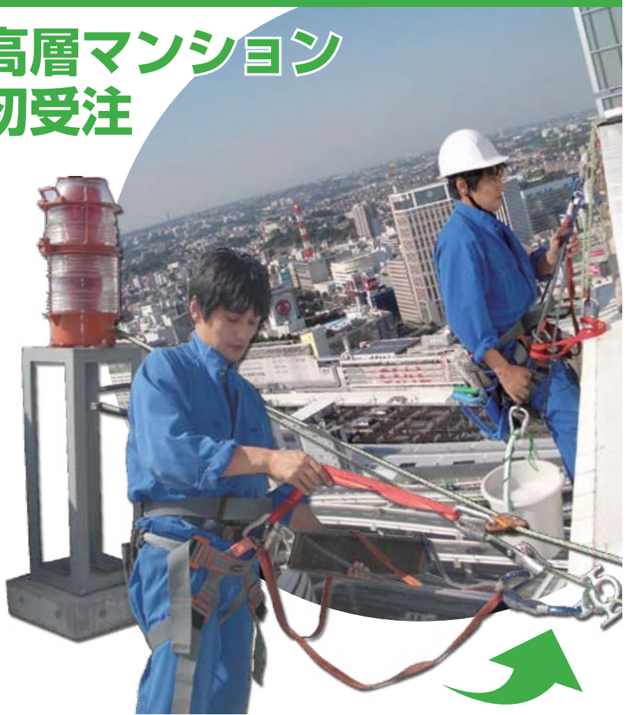
▲屋上(地上150メートル)で命綱を点検します。(写真左) 清掃用具を体にセットして降下開始。見ている方が目がくらみます。(写真右)
